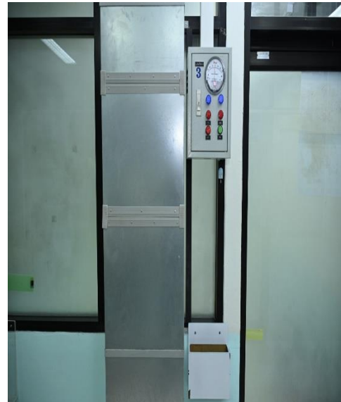
รูปที่ 2 ระบบท่อดูดเพื่อระบายอากาศออก
