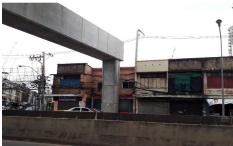
ภาพที่ 1 เสาดอม่อที่เข้ามาบังหน้าบ้าน ทำให้ต้องมีการติดบ้านเพื่อเว้นพื้นที่ไว้สำหรับการก่อสร้าง
