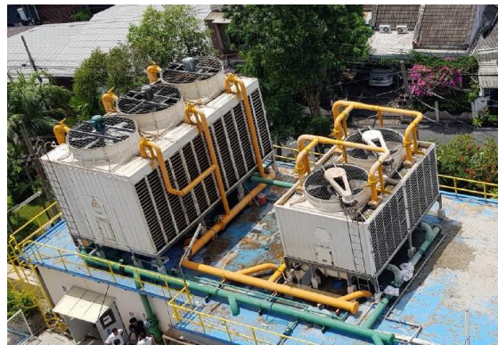
ภาพที่ 1 งานเปลี่ยนท่อ Cooling Tower ก่อนปรับปรุง
