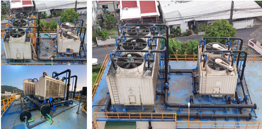
ภาพที่ 2 งานเปลี่ยนท่อ Cooling Tower (หลังดำเนินการแล้วเสร็จ) เพื่อเพิ่มประสิทธิภาพการระบายความร้อนของเครื่อง Chiller
