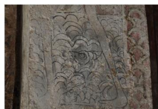
จิตรกรรมบนเสาระหว่างแผงคอสองภายใน วิหารน้ำแต้ม
