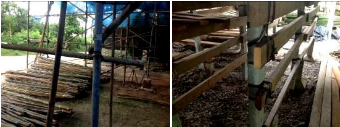
ภาพที่ 8 ตัวอย่างการใช้สายยางยึดในการผูกมัดไม้กับเหล็กและปูน ซึ่งถือเป็นองค์ประกอบทางสถาปัตยกรรมรูปแบบใหม่ที่เกิดขึ้น
