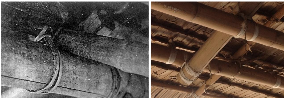
ภาพที่ 9 เปรียบเทียบการใช้หวายในเรือนเครื่องผูกแบบโบราณกับการใช้สายยางยึดในสิ่งปลูกสร้างท้องถิ่น ที่มา : (เสนอ, 2541)
