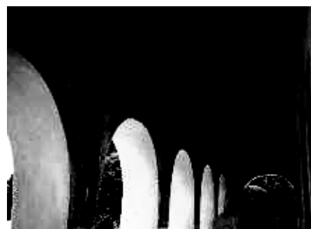
ภาพที่ 17 ช่องโค้งรับหลังคาพาไล อุโบสถวัดมัสฌิมาราม
