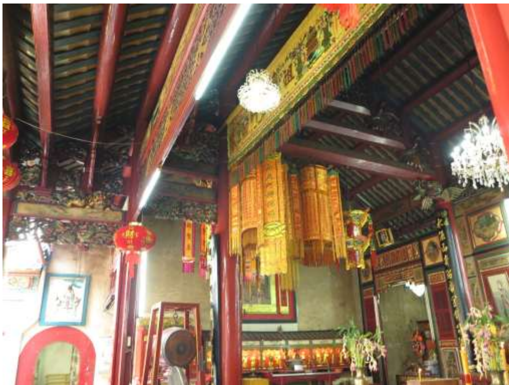
ภาพที่ 2 ชุดโครงสร้างไม้ภายในศาลเจ้าโจซือก่ง (ฮกเกี้ยน) สมัยรัชกาลที่ 1 ราวกลางพุทธศตวรรษที่ 24 สังเกตได้ว่าชุดโครงสร้างไม้หรือโถงเจ็ยที่จะตั้งขนานกับด้านกว้างของอาคาร แต่ละชุดมีไม้แปะเชื่อม
