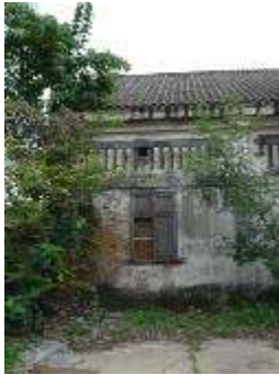
รูปที่ 6. ผนังด้านทิศใต้ที่มูมด้านทิศตะวันตกที่มีการทรุดตัวมาก จนผนังแตกกร้าว
