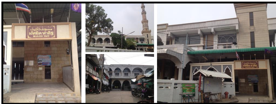
ภาพที่ 4 ลักษณะพื้นที่ภายนอก
