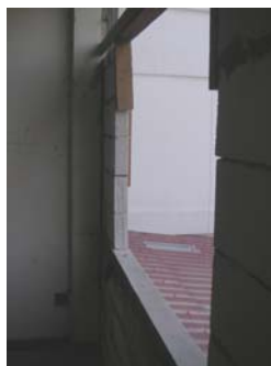
ภาพที่ 2 ผนังห้องทดลองคอนกรีตมวลเบา 1 ชั้น
