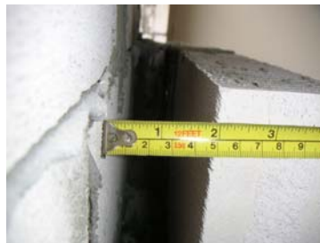
ภาพที่ 1 การทำผนังห้องทดลองด้วยผนังคอนกรีตมวลเบา 2 ชั้น
