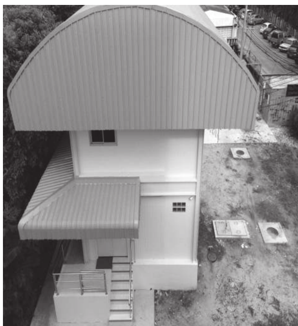
ภาพที่ 1 อาคารคลังวัคซีนมาตรฐานของภูมิภาค
