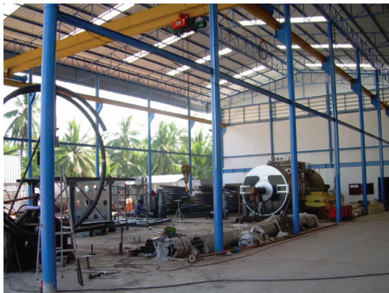
รูปที่ 3 ลักษณะโรงงานเป็นโรงเรือนเปิดโล่ง มีต้นไม้ และทุ่งหญ้าอยู่รอบ
