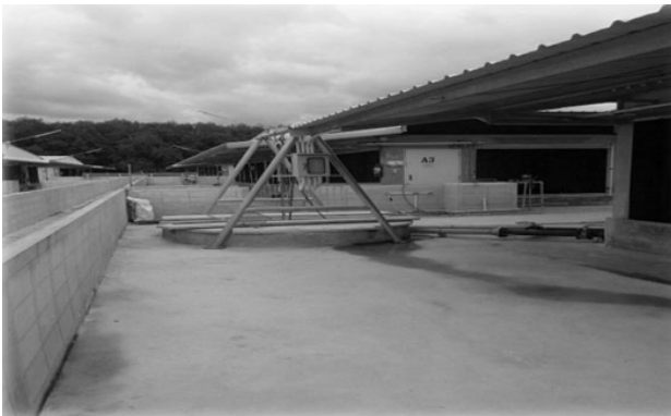
รูปที่ 2ก บ่อพักของเสีย
