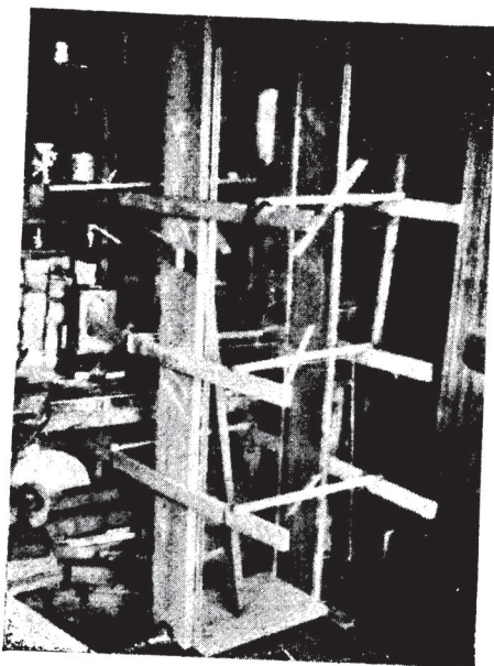
รูป ๒. แสดงวิธีอัดชั้นต่างๆ ให้เข้าที่ก่อนเชื่อม
